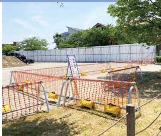
バリケード+プラットウォール 施工事例
