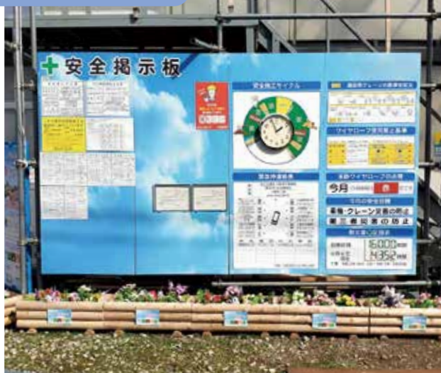
安全掲示板 設置事例
